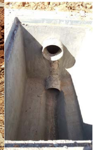
Pas-stuk voor ontstopping riolering
